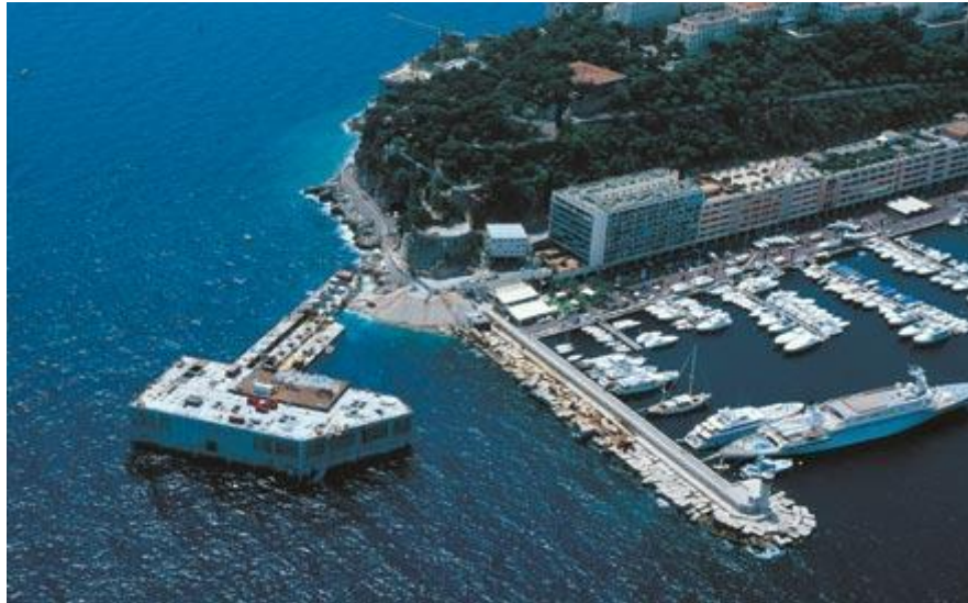
Figure 4 : aménagement du port de Monaco (béton en milieu agressif)
