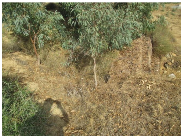
Photo 8 : Renforcement des seuils par de l'Eucalyptus
