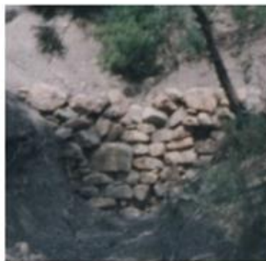
Seuil en pierre sèche
