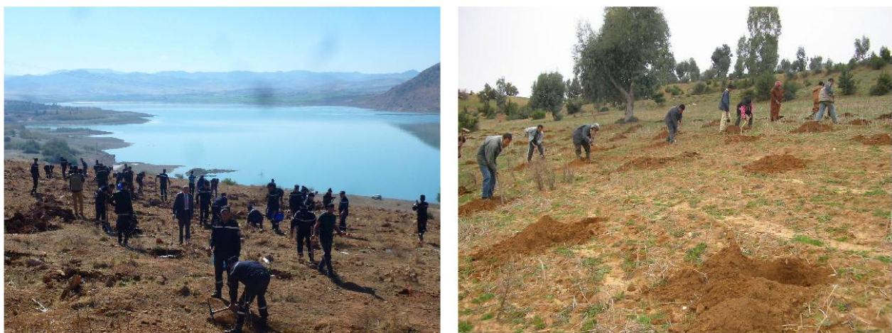
Photo 5 : Ouverture des potets de plantation pour la fixation biologique du versant
