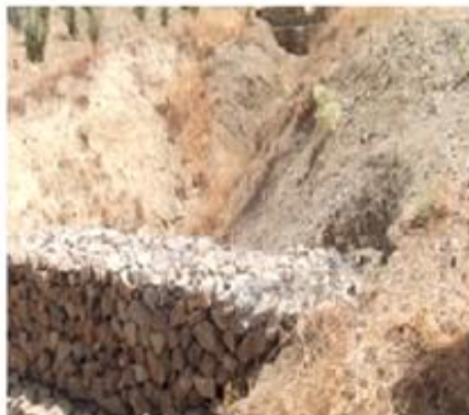
Seuil en gabion
