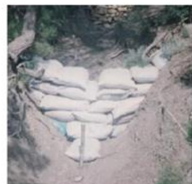
Seuil en sacs plastiques
