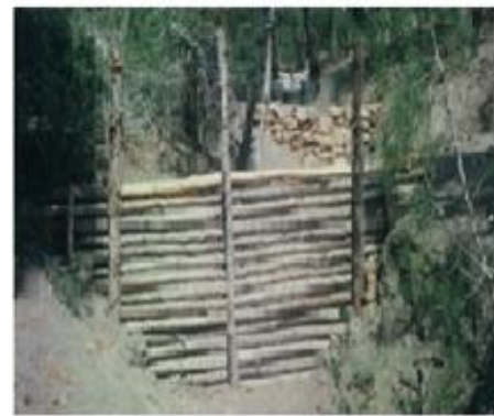
Seuil en traverses de bois
