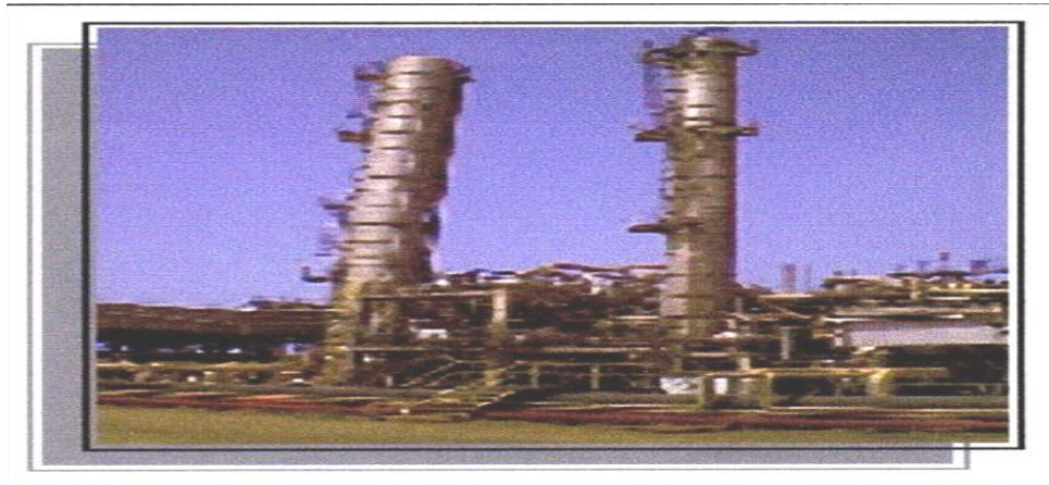
Figure I.11: les deux colonnes de distillation
