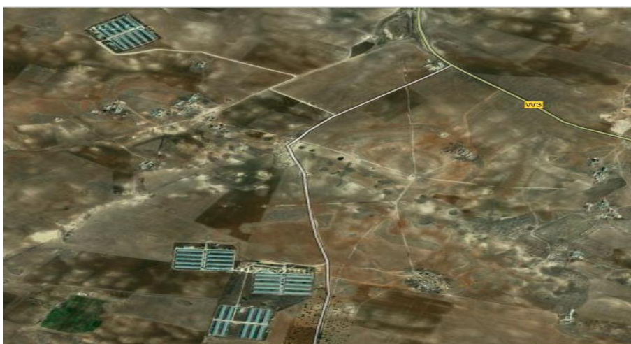
Figure II.4. : Vue du site par satellite (Google Earth)
