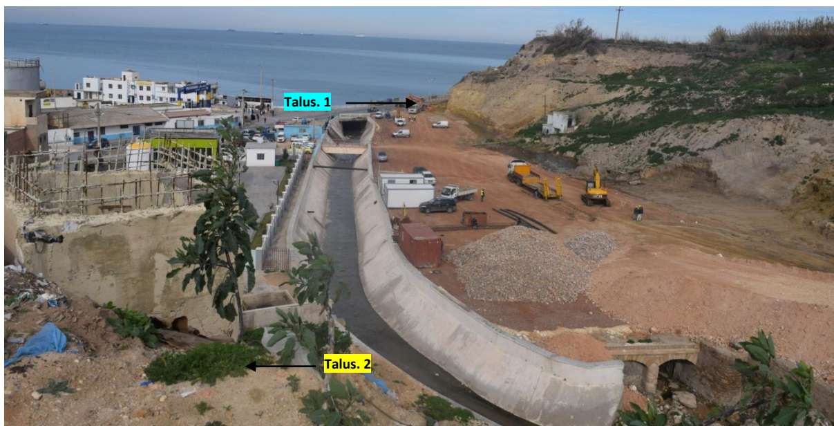
Figure VI 7.1 : Vue panoramique de la partie aval de l'Oued Ain Sefra
