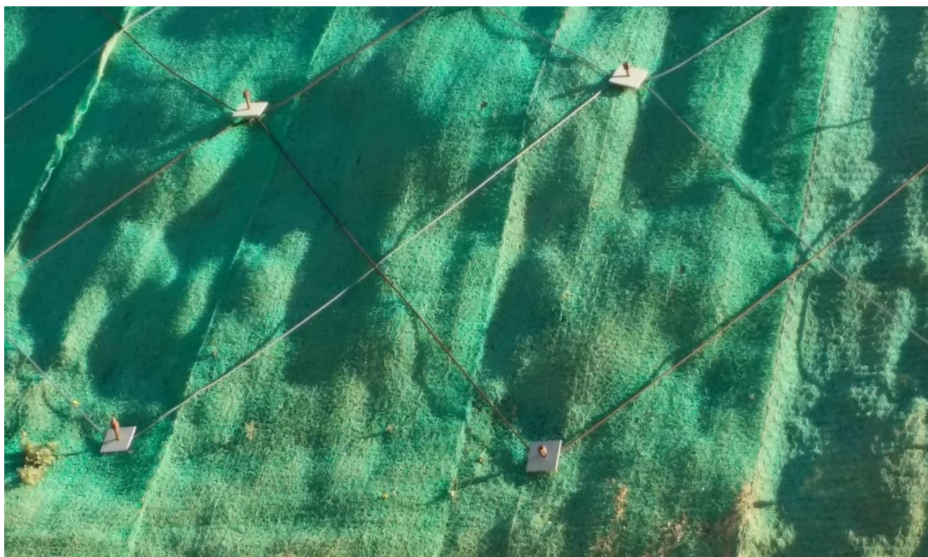
Photo VI.20 : présente talus après traitement avec la terre armée
