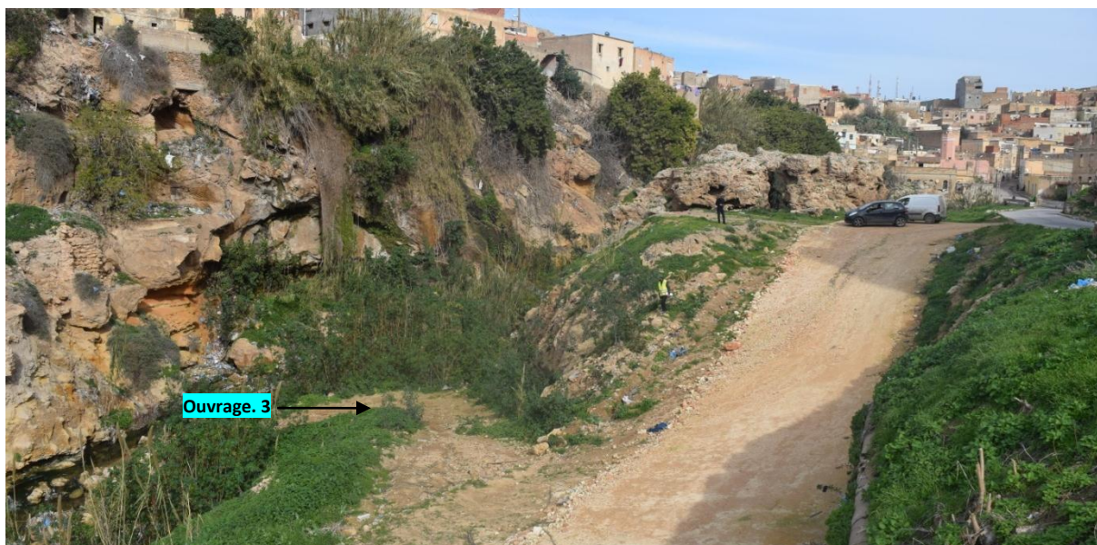
Figure VI.7.2 .: Vue panoramique de la partie amont (par rapport au projet) de l'Oued Ain Sefra
