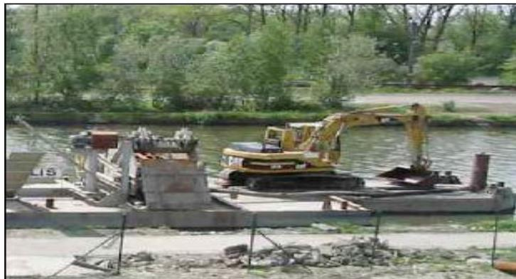
Figure IV.2: Engin mécanique de dragage [73].
