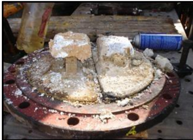
Figure III.6. les anodes sacrificielles couverts par les dépôts.
