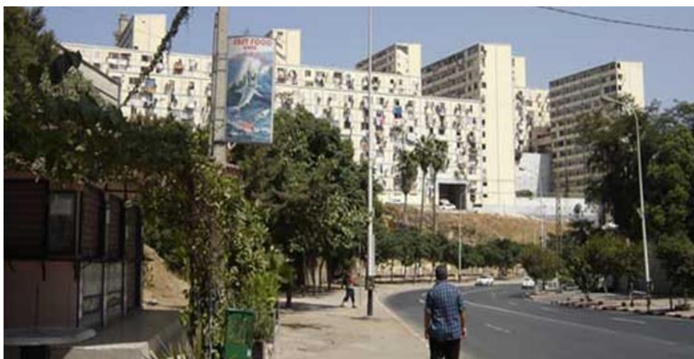
Figure 80: La cité Diar Es Chams, Alger. Source : Babel Med, Des vies de bric et de broc.
