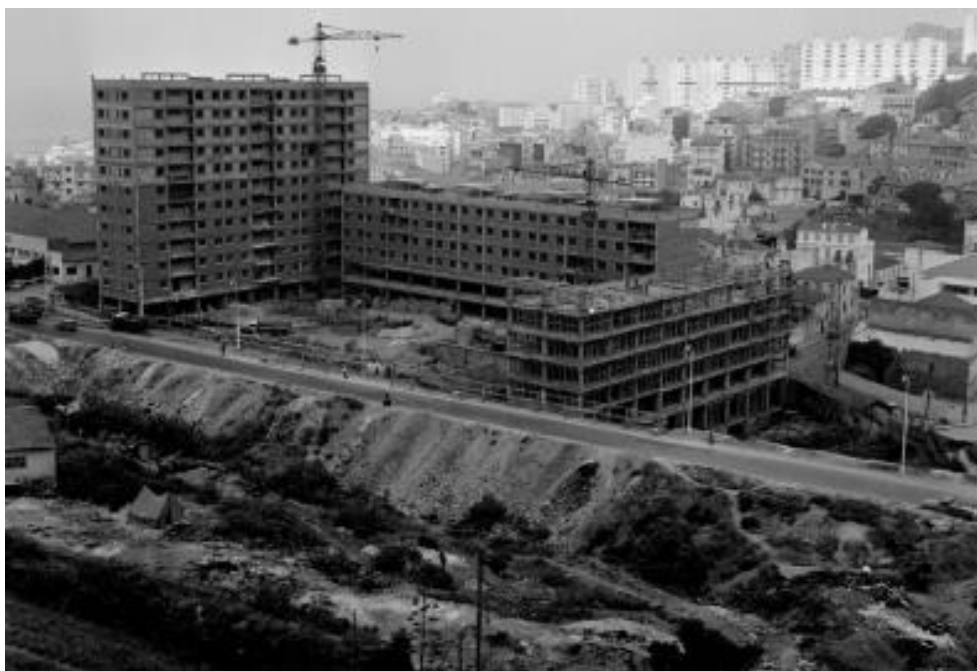
Figure 72: Première tranche des travaux à Diar El-Keff dans un quartier périphérique d'Alger, dans le cadre du plan de Constantine. juillet 1959.
