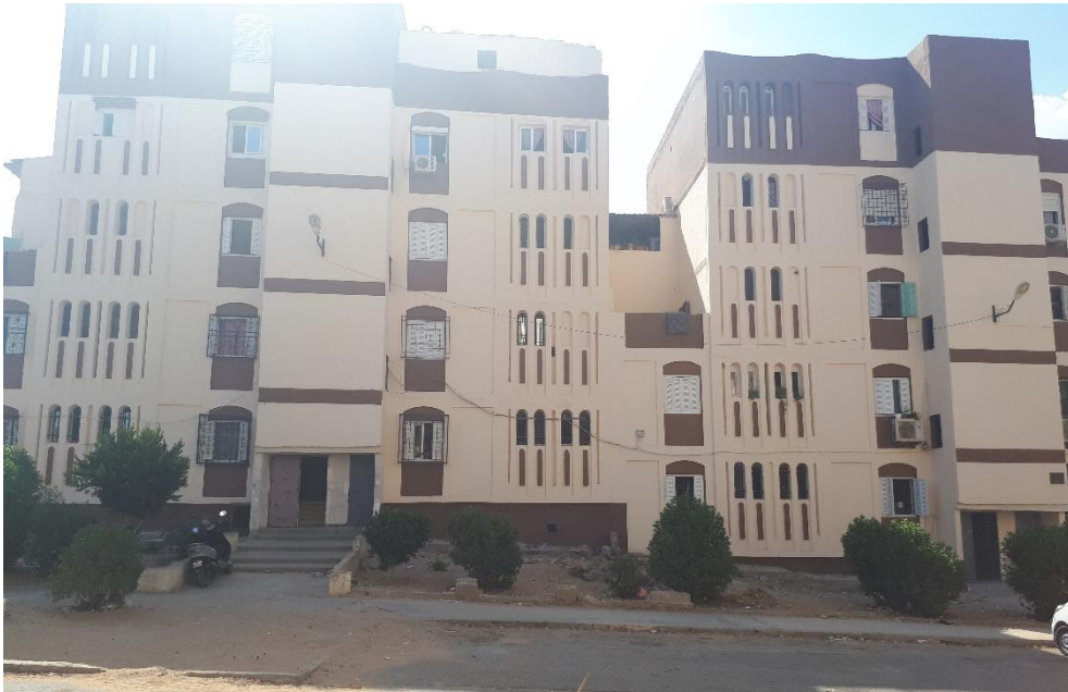
Figure 130: Nouvelle image des façades après l'opération du ravalement.
