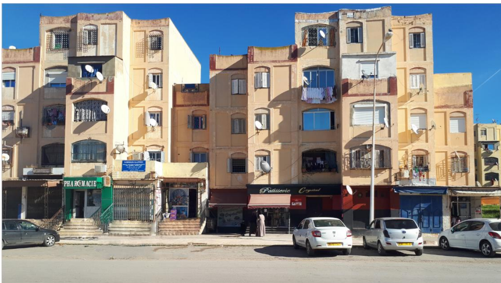
Figure 129: façade principale d'une barre avec des locaux commerciaux.
