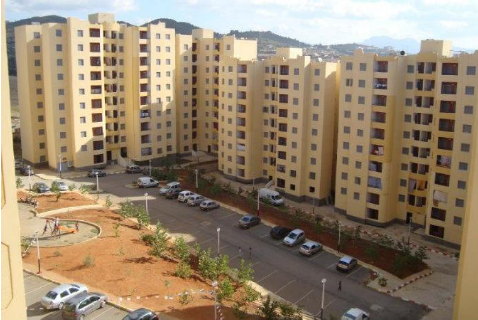
Figure 111: Exemple de logements AADL à Boumerdes Source : eldjazair365.com
