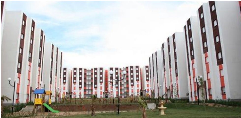
Figure 113: Exemple d'un logement LPA ex LSP à Oran Source : Internet
