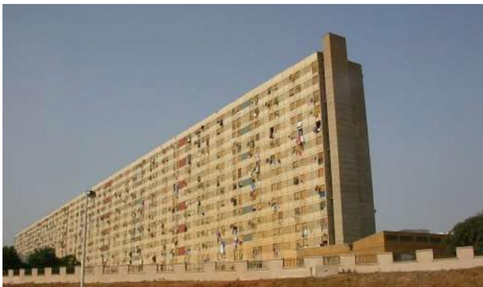
Figure 79: Cité les Dunes, El Harrach, Alger, Régeste et Bellissent, 1959. Source : Wikipédia l'encyclopédie libre.
