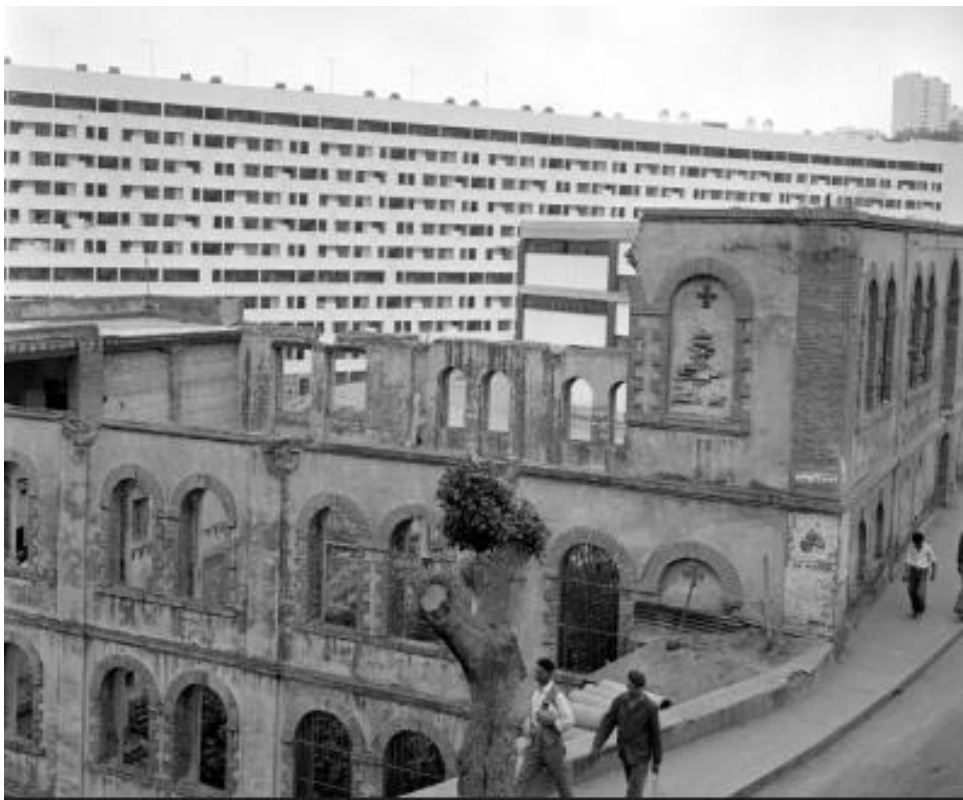
70: Conséquences du plan de Constantine, une barre d'immeubles imposante contraste avec des ruines anciennes situées sur les hauteurs d'Alger.
