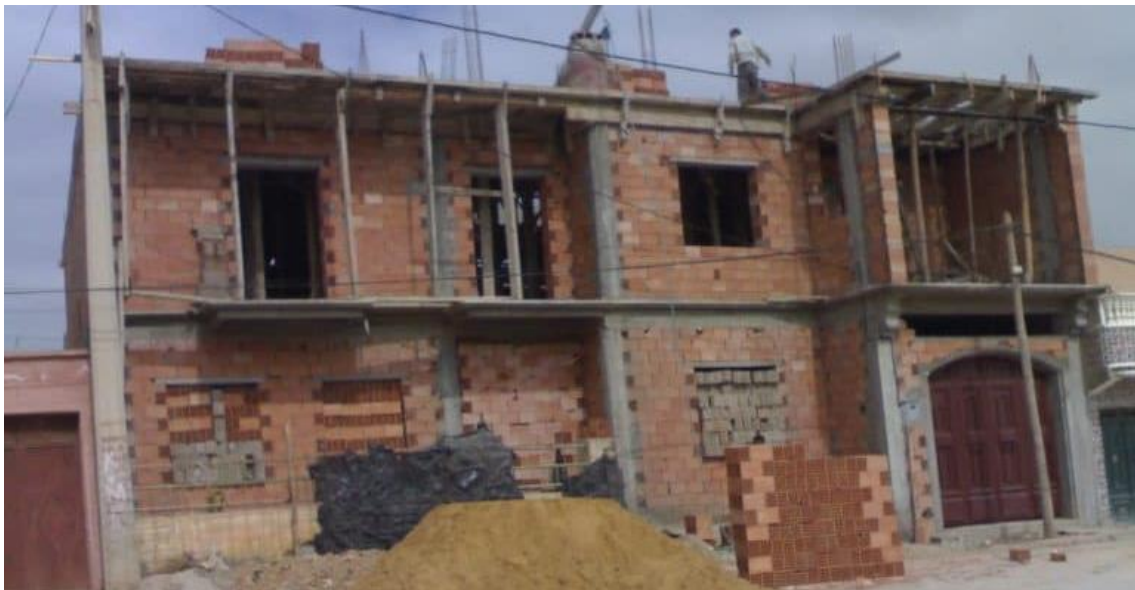
Figure 117: Exemple d'un habitat auto-construit en Algérie Source : www.algerie-focus.com
