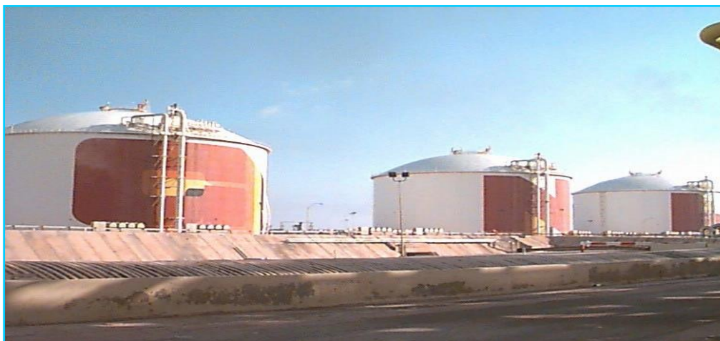
Figure I.2 : Zone de stockage et chargement
