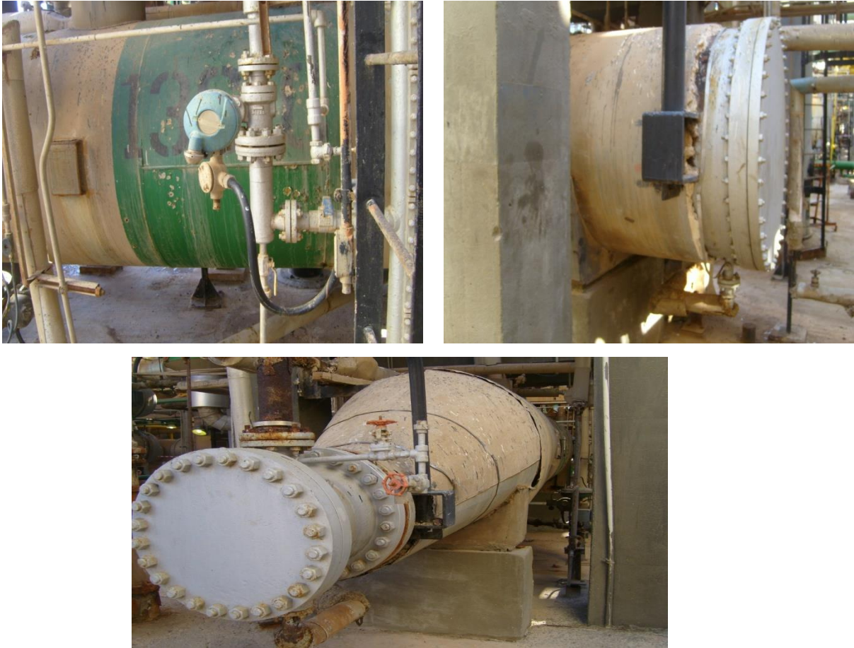
figure.VI.3 : Le vaporiseur X36C
