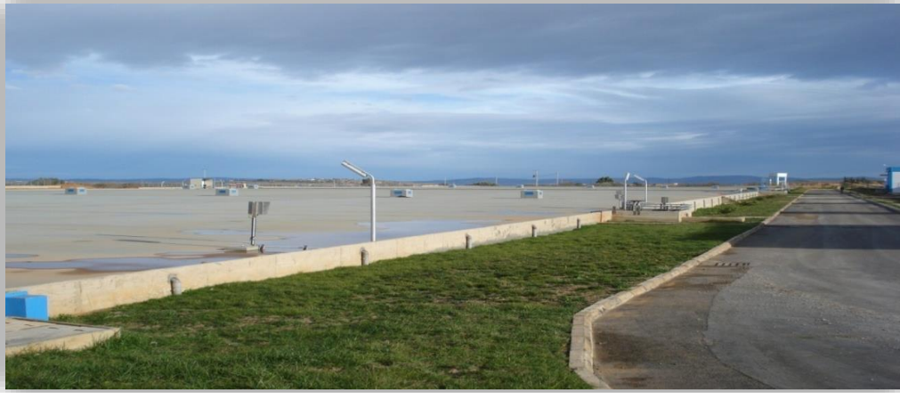
Figure. II.9 Réservoir de stockage (A/B)
