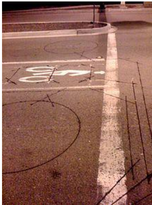
Boucle d'induction magnétique installée sur une route pour détecter les voitures.
