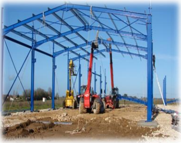
La construction métallique
