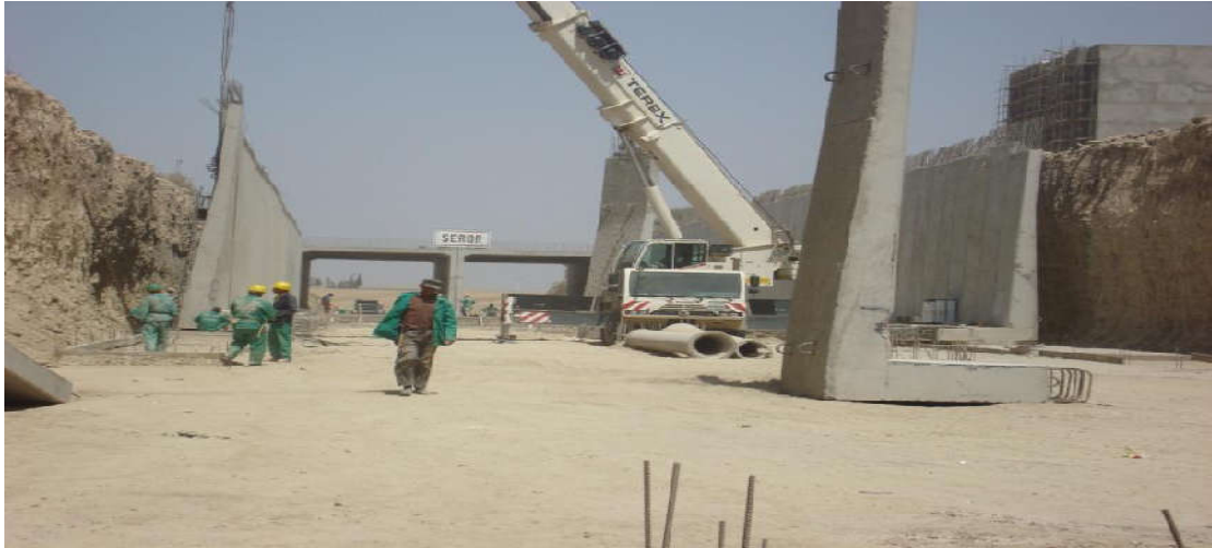
Figure IV :1 Mur de soutènement d'une trémie
