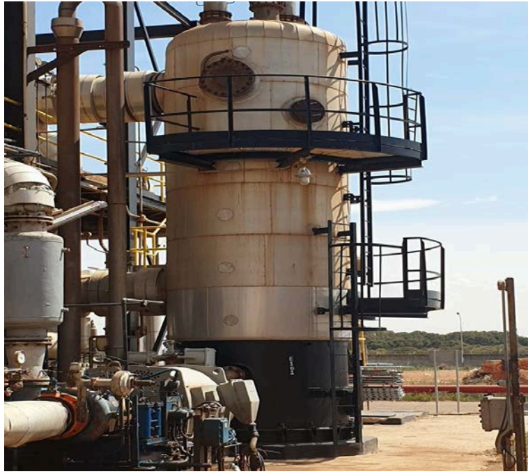
Figure I.5: Echangeur gaz-gza E102 A/B
