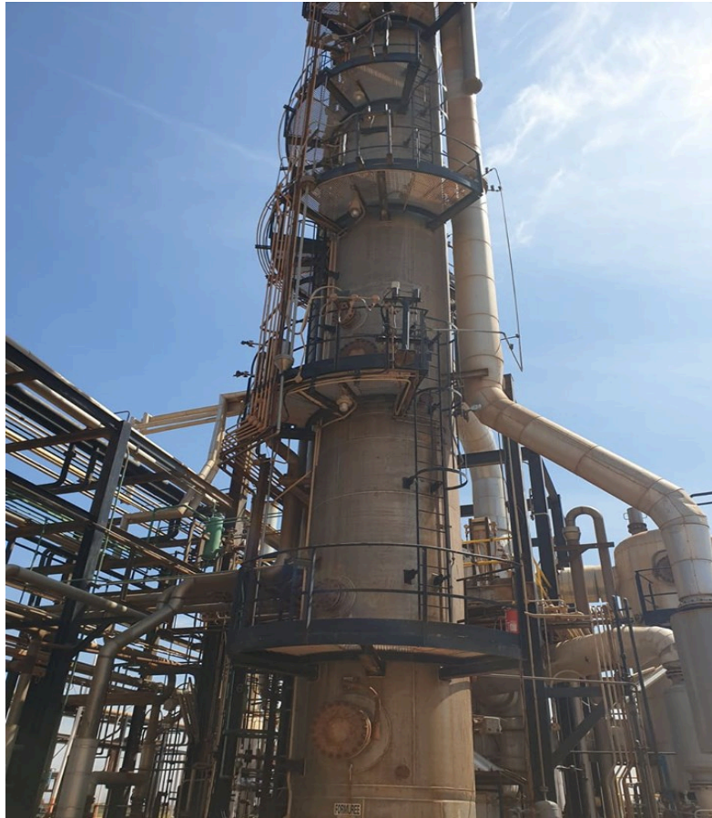
Figure I.9: Colonne d'absorption C101
