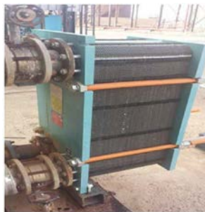
Figure I.8 : Échangeur a plaques.
