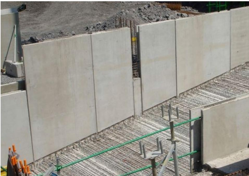
**Figure 1 :** Mur voile en Béton Armé.
