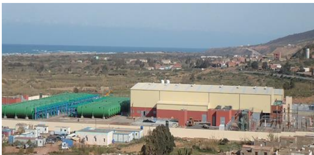
Figure I.3: une vue générale de l'usine de dessalement de Mostaganem
