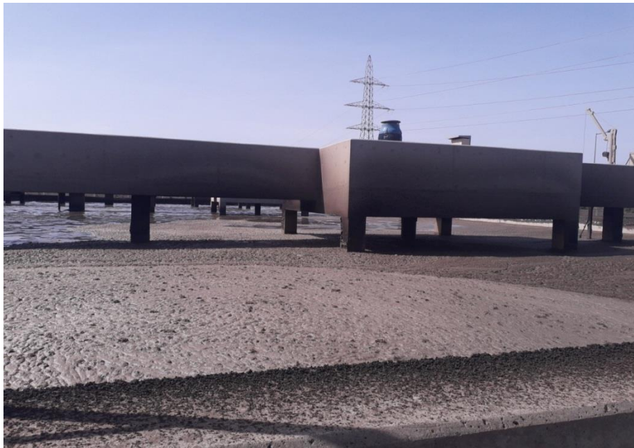
Figure 14 : Le Bassin biologique (le bassin d'aération).
