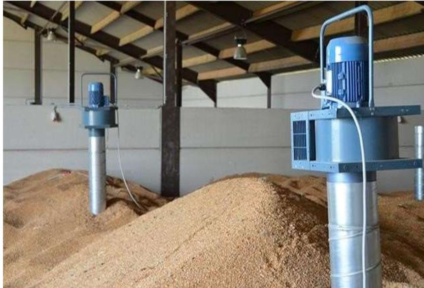
**Figure 11 :** Ventilation par aspiration (dépression) des céréales (Anonyme, 2021)
