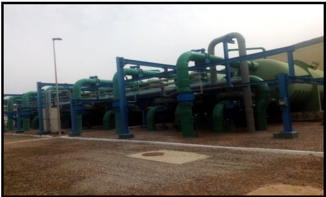
Figure 9 : Filtration de deuxième étape (8 filtres)
