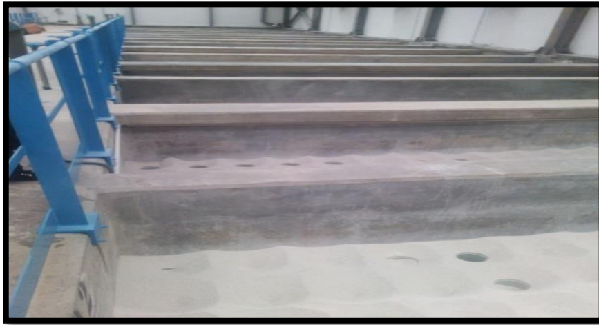
Figure 12 : Système de reminéralisation de l'eau osmosée
