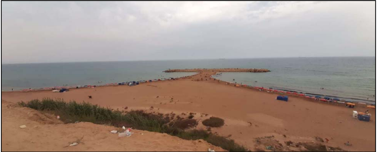
Figure 9 : Les brise-lames de la station de Sidi Medjdoub. (Photo prise par Ellabed Bouchra, 2021).
