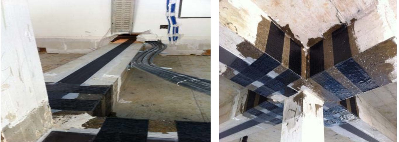
Figure II.4: Poutres en BA renforcées par matériaux composites.
