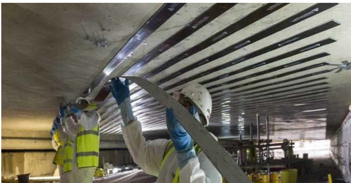
Figure II.5: Dalle renforcé par matériaux composites.
