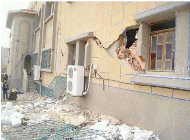
Figure 1.17. Effondrement de la maçonnerie
