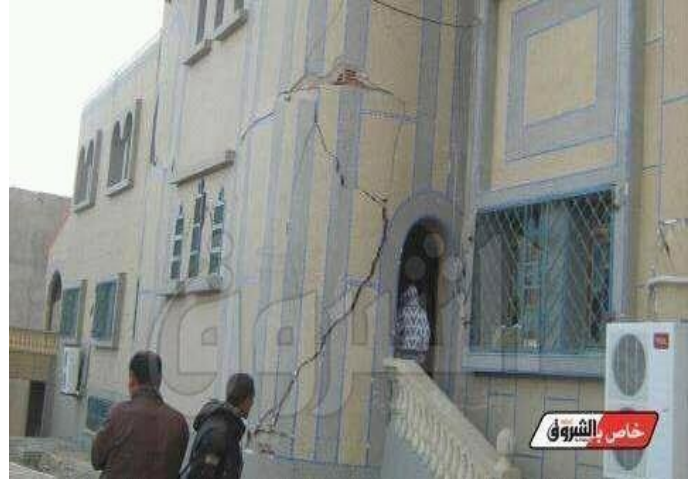
Figure 1.17. Effondrement de la maçonnerie
