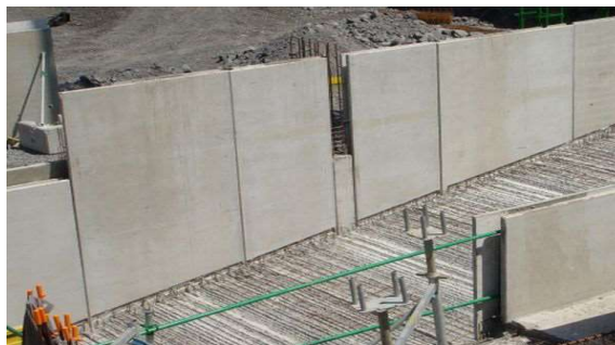
Figure 1.1 : Mur voile en Béton Armée
