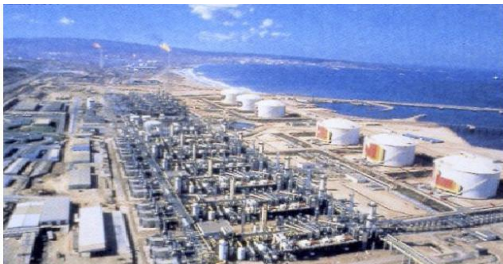
Figure 1.3 : Vue général d'une usine de liquéfaction de gaz naturel
