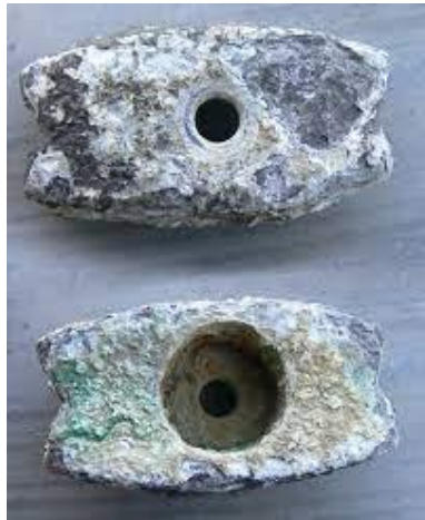
Figure 3.5: Les anodes sacrificielles couvertes par les dépôts
