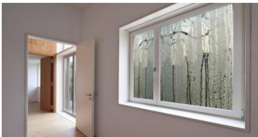
Figure 23: Exemple sur la condensation.
