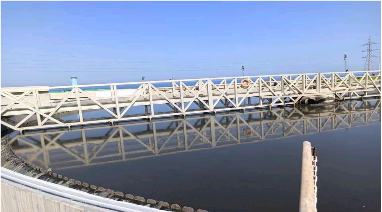
Figure 6 : Décanteur primaire.
