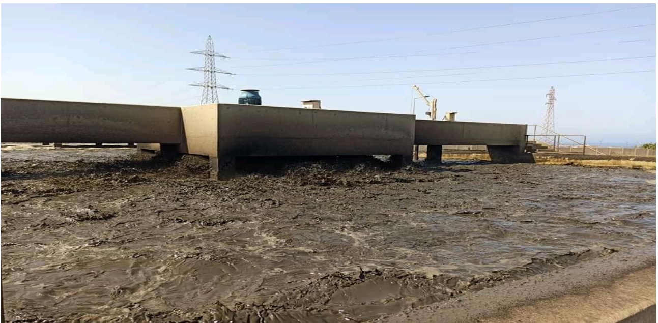
Figure 8 : Bassin biologique (Bassin d'aération).
