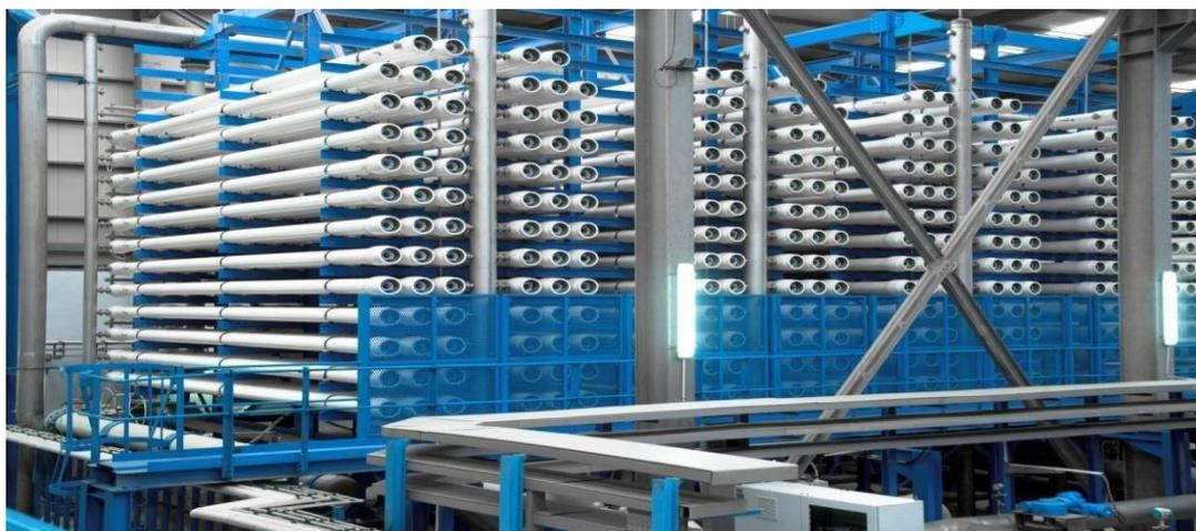
**Figure I<sub>B</sub>.17:** Les châssis d'osmose inverse.
