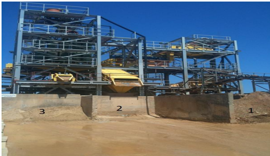
Figure I.9 : Station de lavage du sable
