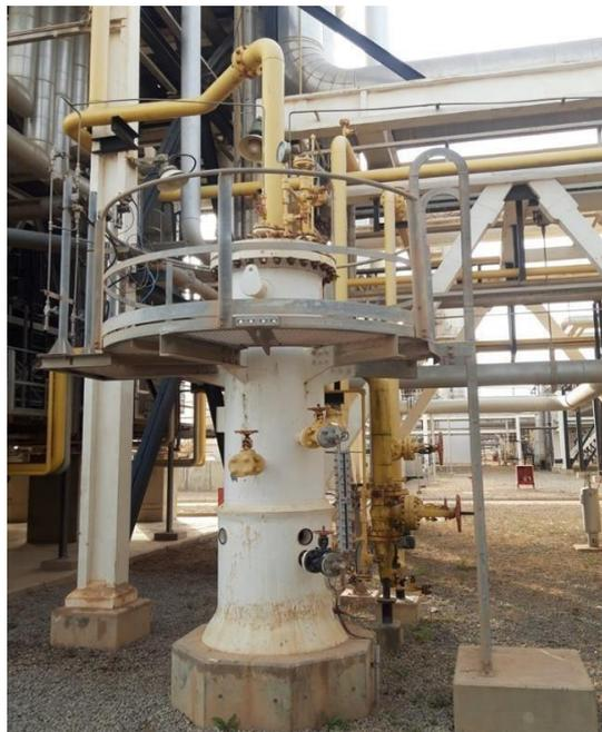
figure II.9 : Ballon tampon du gaz combustible
