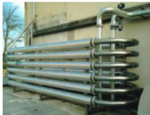
Figure I.7: Échangeur coaxial.
