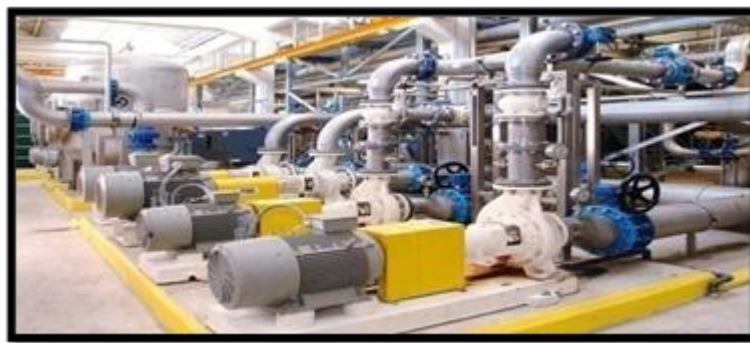
Figure II-2.1 : Système de pompage de l'eau de mer
