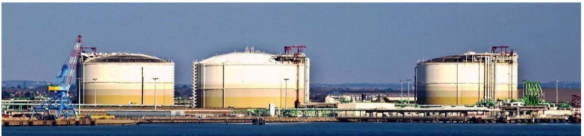
Figure I.3 : bacs de stockages
