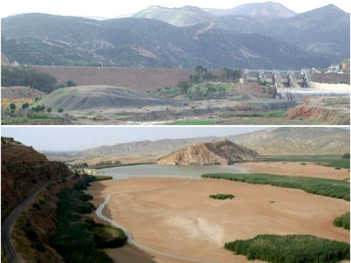
Figure III.7: Etat actuel du barrage de Fergoug
