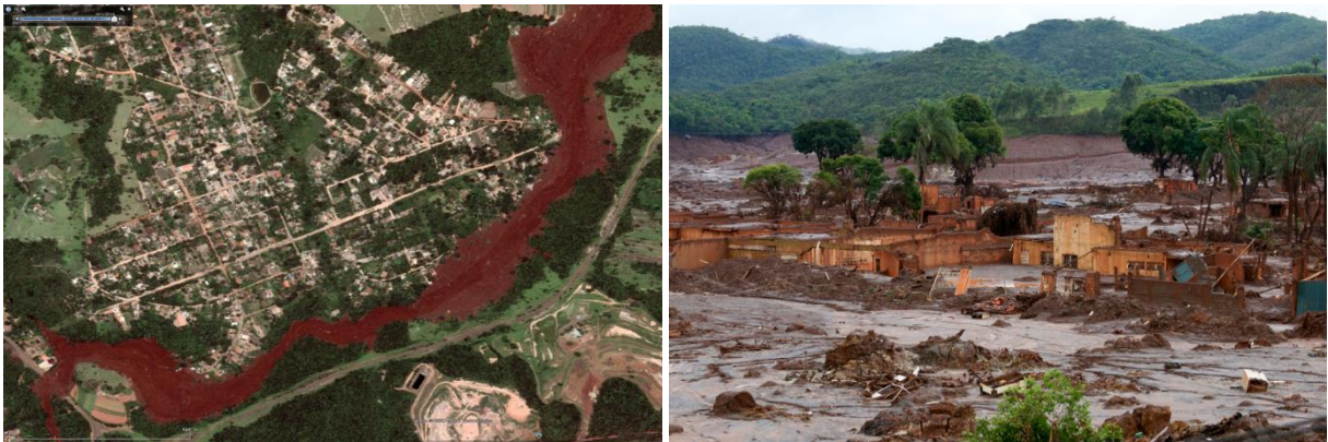
Figure I.6: Dégâts dus à la rupture d'un barrage au Brésil 15
