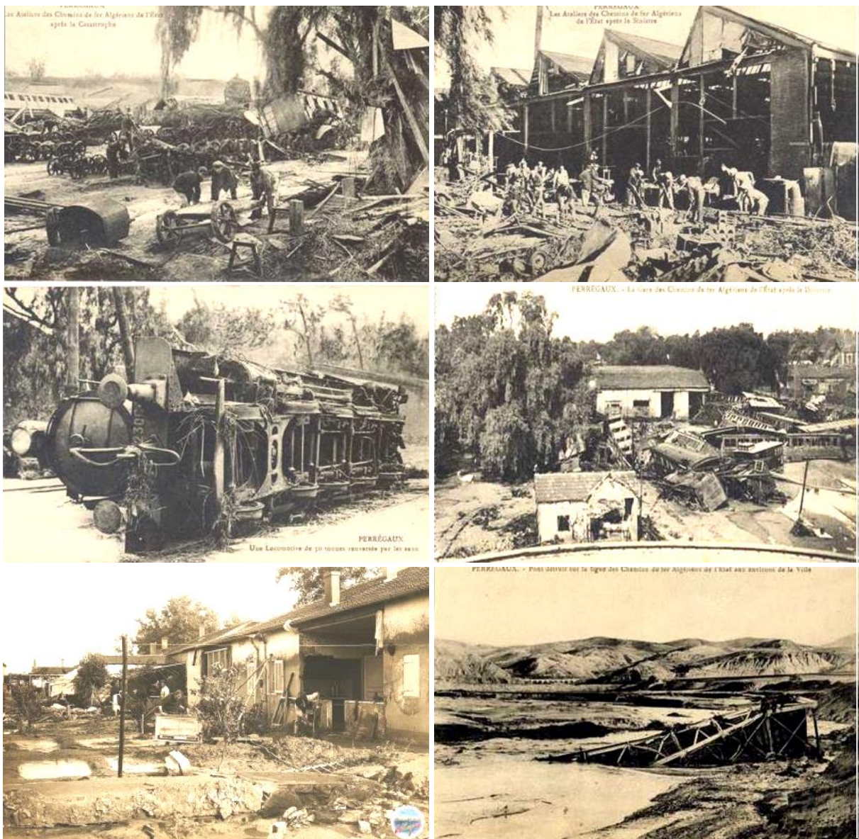
Figure III.5: Dommages causés suite à la rupture du barrage Fergoug en 1927 (a) et (b) les ateliers des chemins de fer après la catastrophe, (c) une locomotive renversée par les eaux, (d) les dégâts au niveau de la gare, (e) les dégâts au niveau des fermes, (f) un pont détruit sur la ligne du chemin de fer (Source: photos d'archives).
