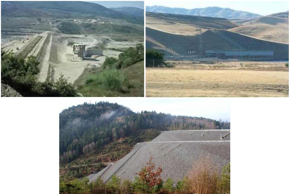
Figure I.1: Types de barrages en terre selon les matériaux de construction (a) Barrage en terre naturelle 9 , (d) Barrages à cumulus 10 , (c) Barrage en pierre 11
