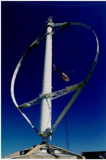
Éolienne de type Darrieus.
