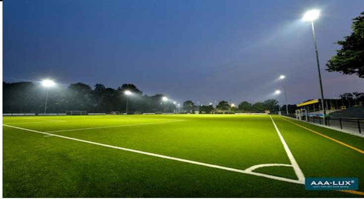
Figure 1.6 : éclairage des espaces sportifs
