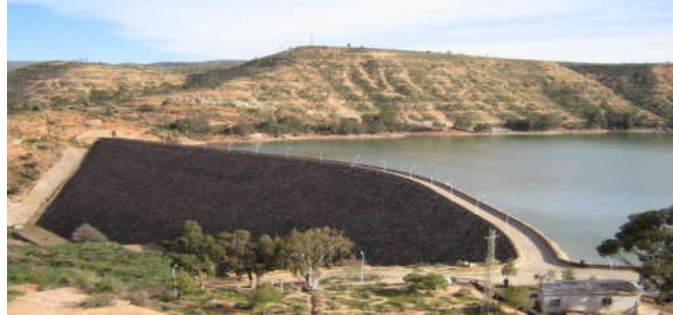
Figure III-5 Le barrage de Bou-Hanifia
