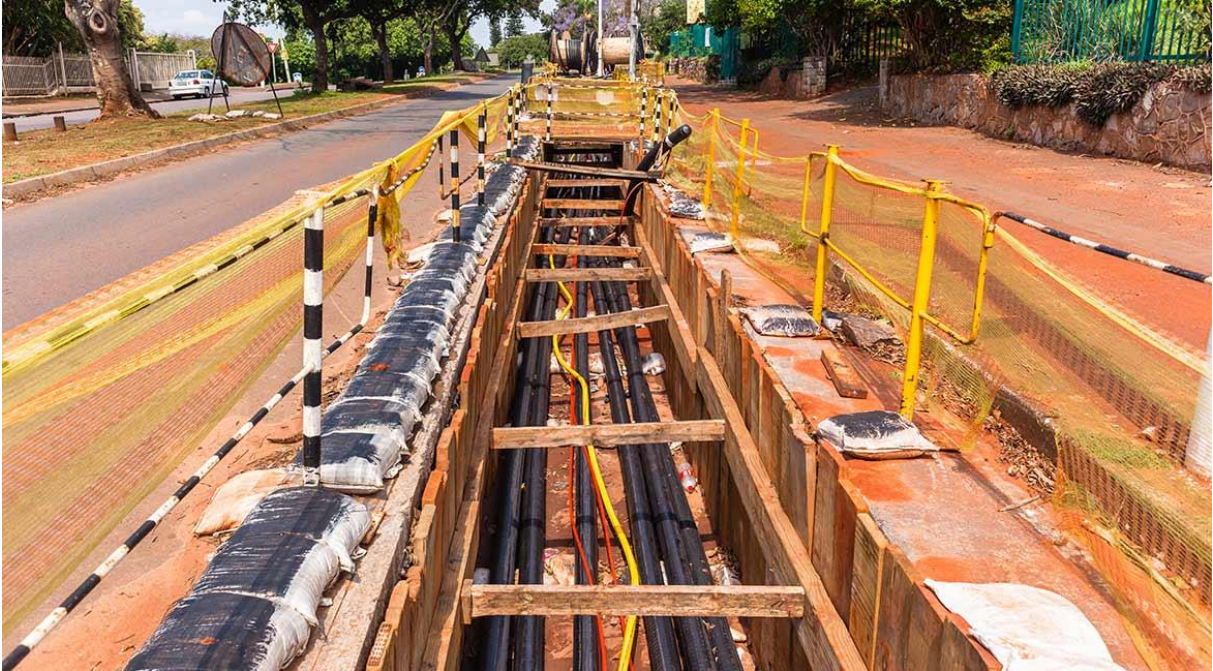
FigureII.5 Câbles souterrains
