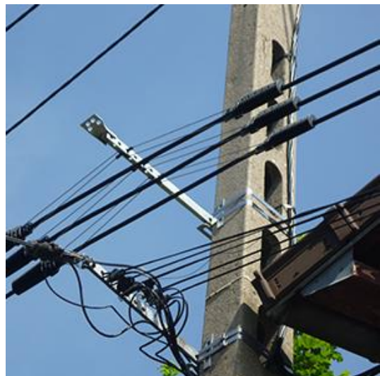
FigureII.3 Les câbles aériens
