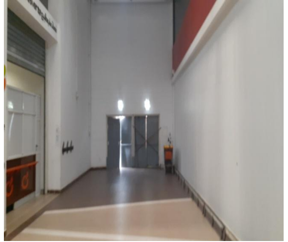
Photo 6 : Eclairage de secours UNO
