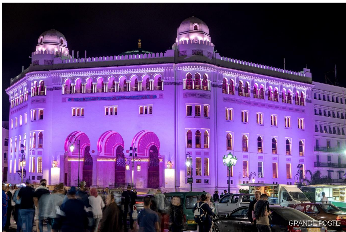
Figure 12 : éclairage de la grande poste d'Alger [21]
