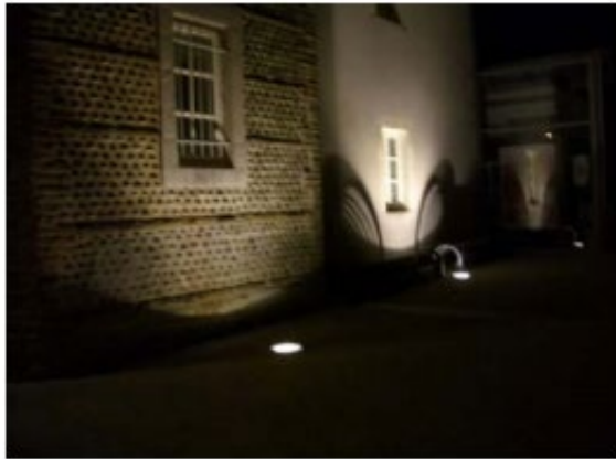
Figure 56 : Bon positionnement idéal d'un Luminaire
