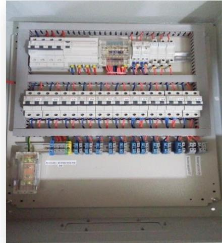
Figure 13 : Coffret de commande et de protection
