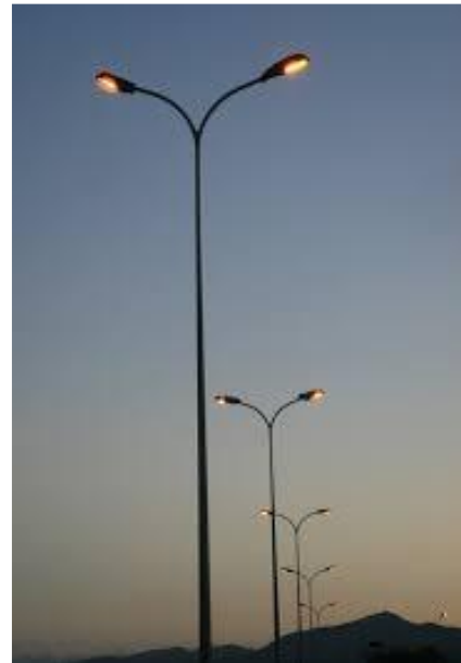
Figure III.12 : Eclairage avec réseau électrique enterré
