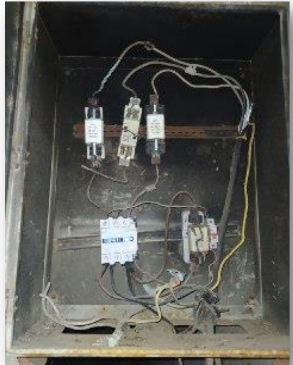
Figure II.7 : Armoire de commande et de protection
