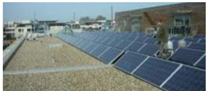
Figure III.9 : intégration des capteurs en toiture terrasse
