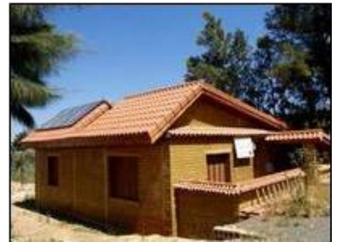
Figure III.24 : Vue du côté Sud et du côté Est de la maison
