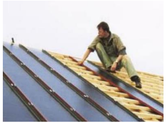
Figure III.8 : Intégration des capteurs en toiture inclinée.
