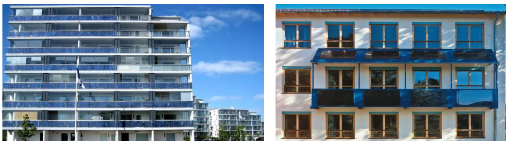
Figure III.11 : Les capteurs solaires en garde-corps.
