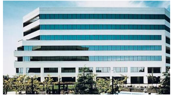
Figure III.10 : Intégrations des capteurs en façade.
