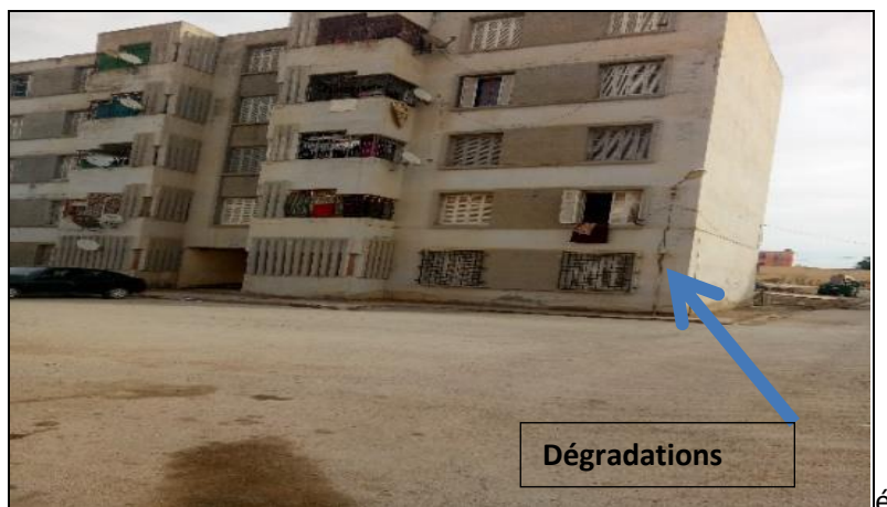
Figure IV.2 : dégradation des bâtiments à Sidi Belattar
