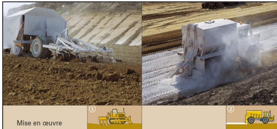
Figure III.12 : Technique d'épandage et Malaxage
