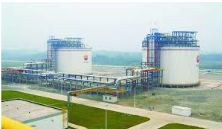
Figure I.1 : Réservoir de stockage
