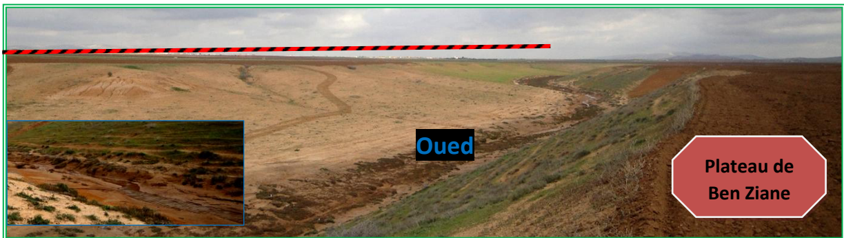
Figure 11: Illustration photographique d'un oued situé à proximité du tracé. Dans cette région, le tracé traverse une zone plate composée d'argile rougeâtre concrétionnée et recouverte par une terre végétale de faible épaisseur.
