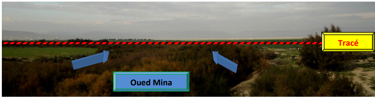
Figure 9: Vue panoramique présentant la zone d'intersection Oued Mina-Tracé (Pk 41+735).
