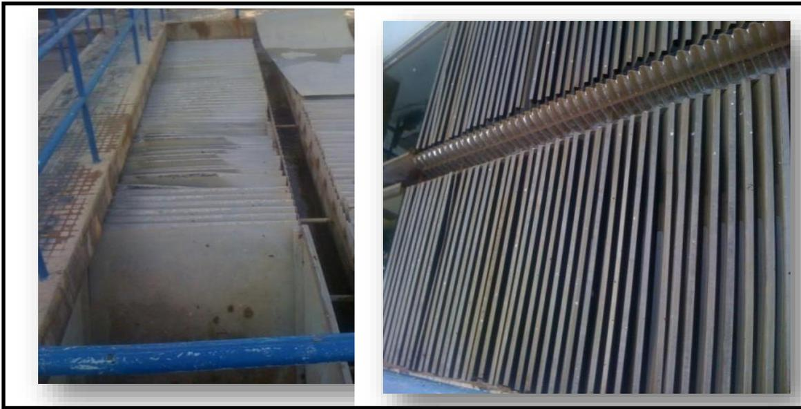
**Figure 6 :** bassin de décantation (type lamellaire).
