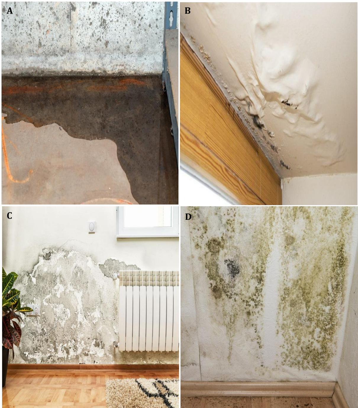
Figure II.3: L'infiltration et l'humidité dus aux inondations (a, b) Infiltrations d'eau où le plancher et le mur fondation et la superficie, (c, d) Conséquences d'un mur humide
