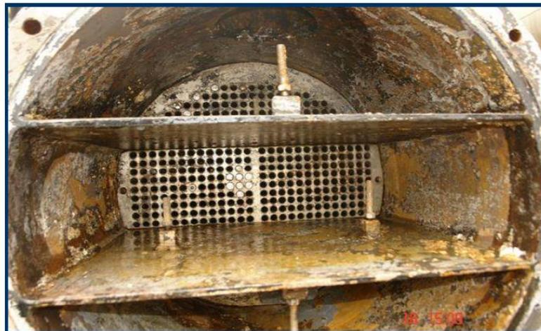
Figure VI.28 : Nettoyage de la Plaque Tubulaire
