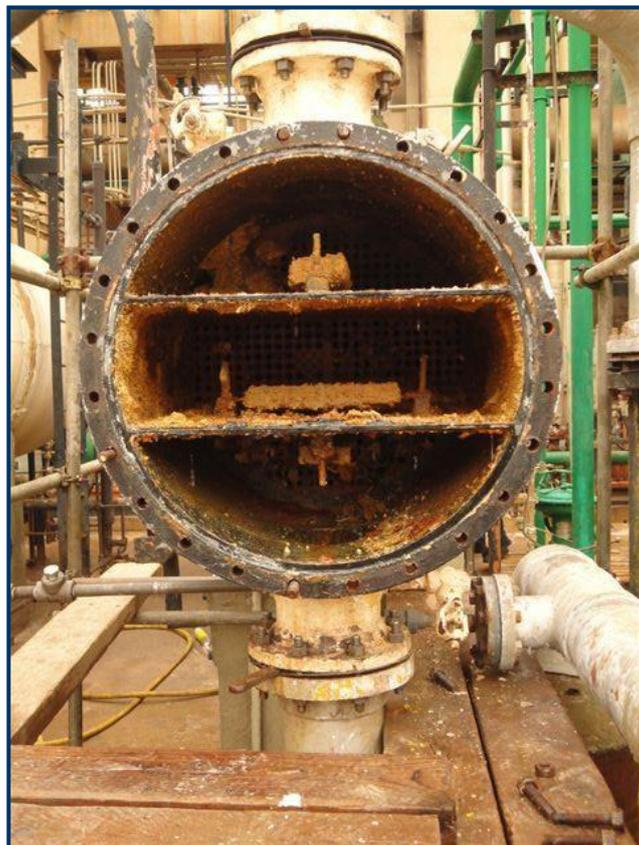
*Figure VI.24 : Corrosion dans Tube Layout*
