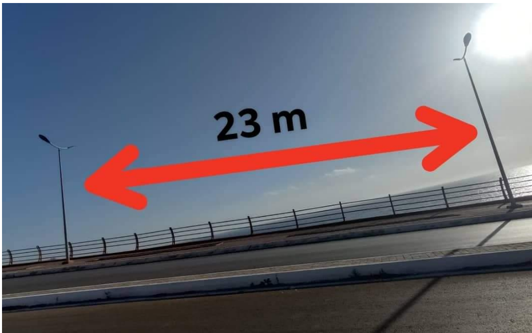
Figure II.12 : Photo réel de distance entre les candélabres
