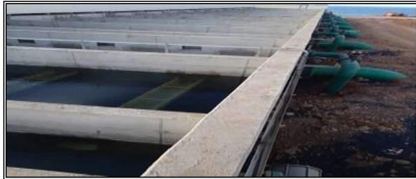
Figure II.9: Filtre à sable.
