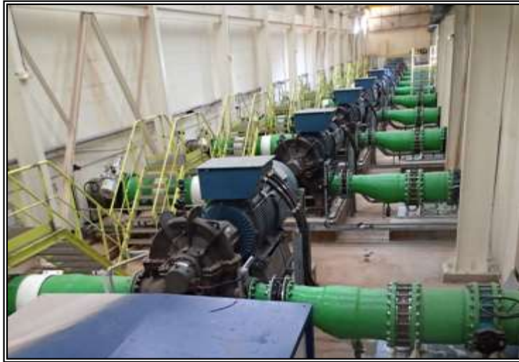
Figure II.11: Pompe HP intermédiaire.
