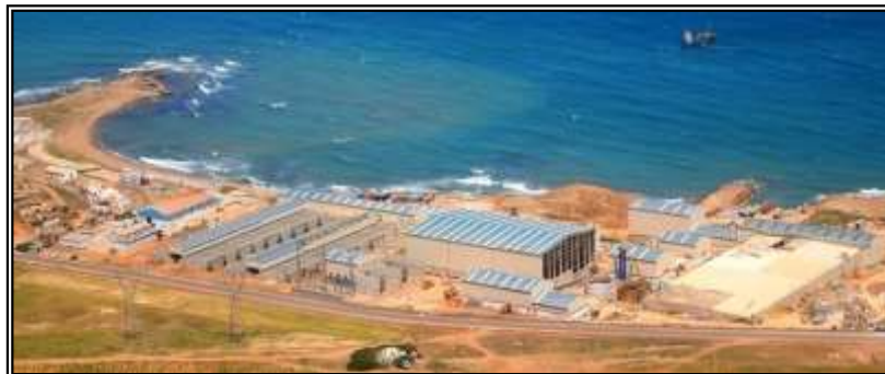
Figure II.4: Vue générale sur la station de Ténès.
