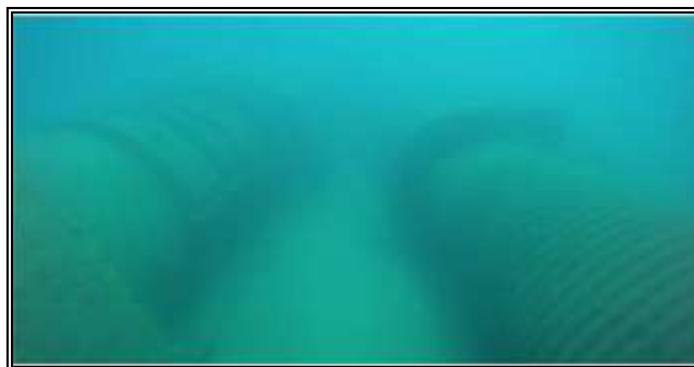
Figure II.6: Tuyaux de captage de l'eau de mer.
